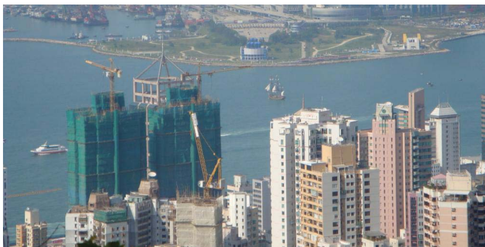
圖 9-8 香港已實施了綜合熱傳值的建築物能源守則，新建的商樓須符合適當的熱傳值
