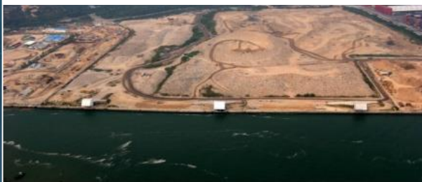
Tuen Mun Fill Bank
